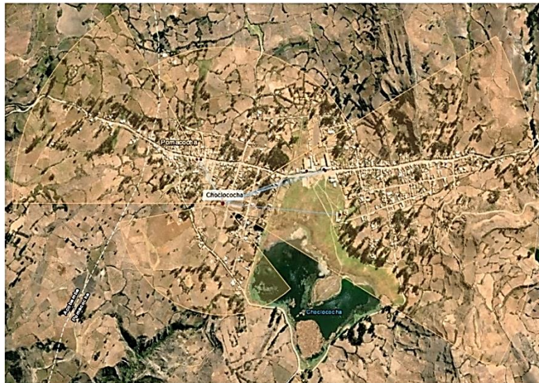
Fig. 10. Cobertura en el centro poblado de Choclococha con cuatro Access Points y sus respectivas antenas sectoriales
